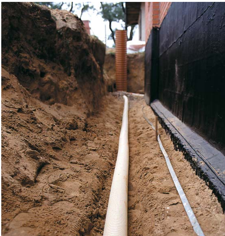
▲ Drenaż opaskowy ułożony wzdłuż ściany fundamentowej. Na końcu widoczna jest studzienka drenarska
