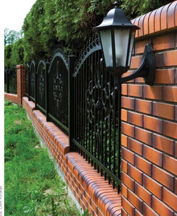
▲▼ Ogrodzenia metalowe mogą być wykonane z płaskowników albo kątowników lub kute ręcznie. Każde z tych rozwiązań jest bardzo estetyczne i łatwo daje się dopasować do stylu domu
