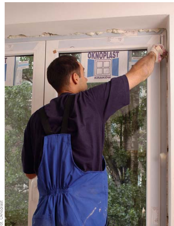
▲ Z punktu widzenia ciepłochronności nie ma żadnego znaczenia, czy w domu zamontowane zostaną okna drewniane, czy też plastikowe. Zarówno jedno, jak i drugie są szczelne i obydwa rodzaje wyposaża się w szyby zespolone o przenikalności cieplnej na poziomie 1,1 W/(m 2 ·K)
