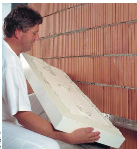
▲ Perforowaną płytę styropianową stosuje się na ścianach o zwiększonej wilgotności, m.in. do termoizolacji obiektów już istniejących
