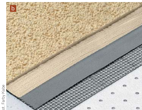
▲ Przekrój systemów ociepleń na bazie a) styropianu, b) styropianu perforowanego, c) wełny mineralnej
