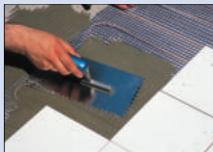
13 Maty pokrywa się warstwą zaprawy klejącej, a do niej bezpośrednio przymocowuje płytki podłogowe (fot. Elektra)
