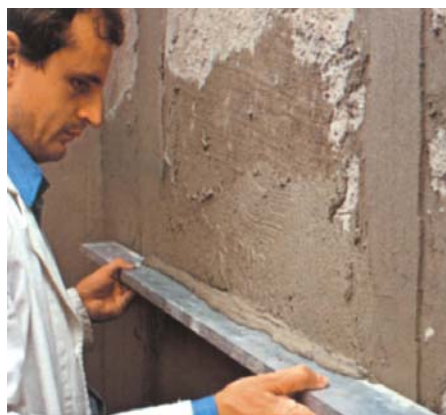
3 Tynki narzuca się pacą, ale potem trzeba go wyrównać (fot. Baumit, Henkel) ▲
