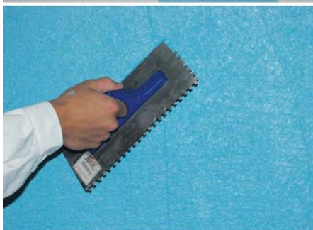
5 Nakładanie tynku cienkowarstwowego (fot. Baumit) ▲
