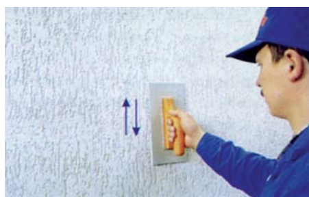
7 Różne faktury tynku uzyskuje się poprzez zacieranie ich pacą w odpowiednich kierunkach (fot. Euro-Mix) ▲
