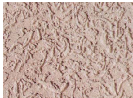
4 Tynki o fakturze kornikowej są bardzo atrakcyjne, ale łatwiej na nich osiada brud (fot. Henkel) ►
