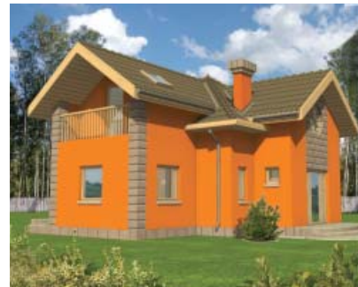
▲ Nie należy wybierać zbyt intensywnego koloru na naszą elewację
