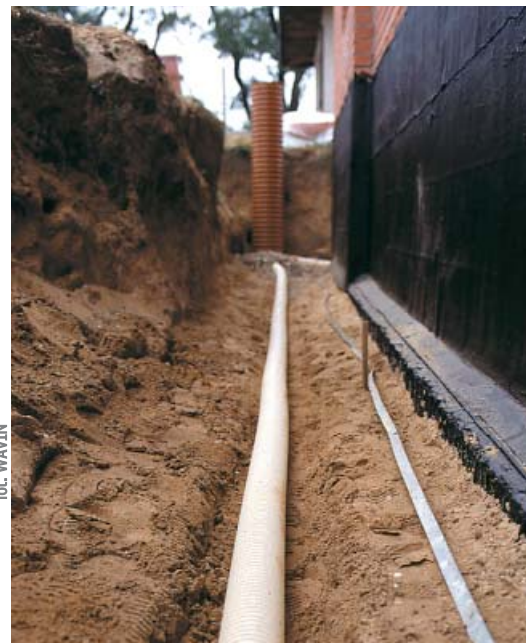
Drenaż wykonany wzdłuż ściany fundamentowej. Na końcu widoczna jest studzienka drenażowa ▼
