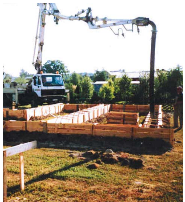
Wylewanie betonu dostarczonego „gruszką”
