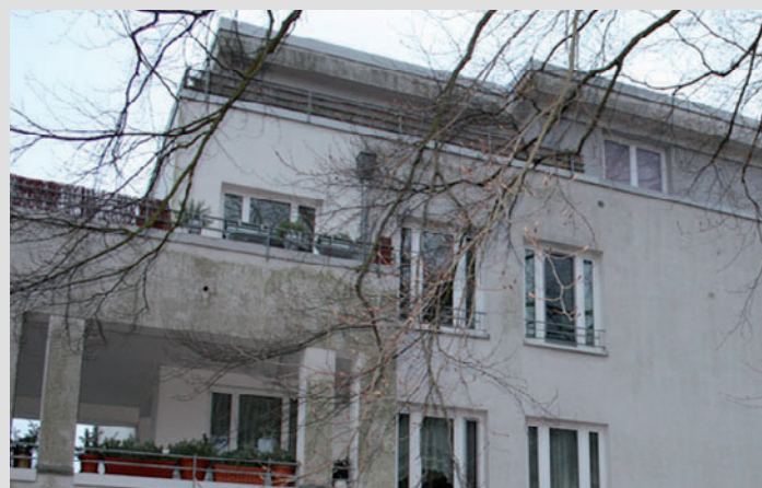
Powierzchnia testowa z powłoką KefaTherm Extérieur na docieplonej fasadzie
