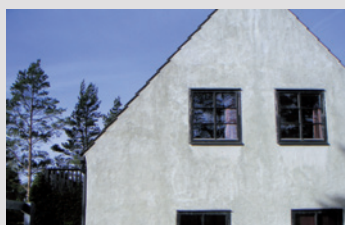
Obiekt przed remontem
