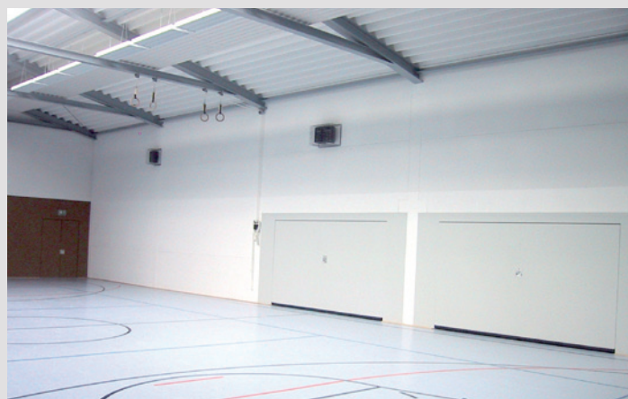
Wykończone wnętrze hali sportowej
