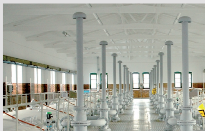
Powłoka KefaTherm w zakładzie wodociągów
