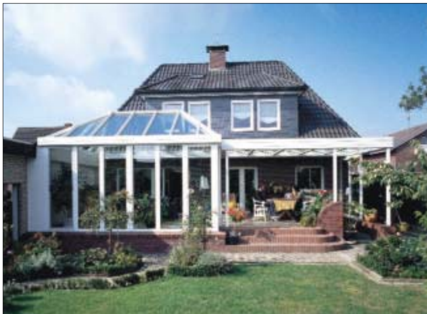
4 Przestronny ogród zimowy stanowi dobrą izolację termiczną budynku (fot. Solarlux)
