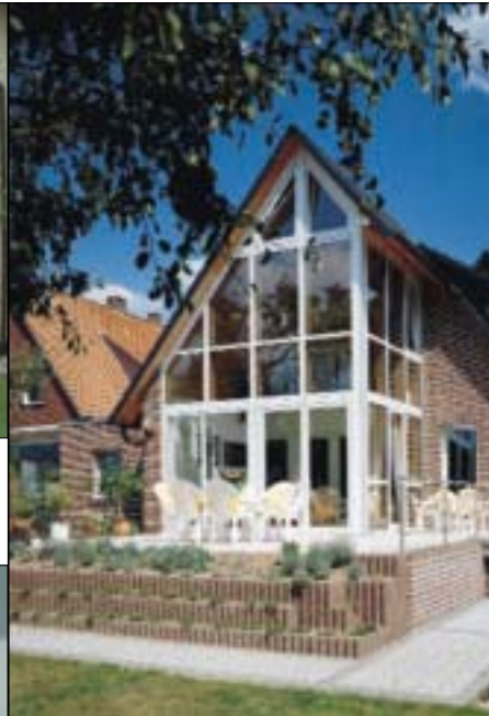
9 Sięgający dachu ogród zimowy dobrze chroni budynek przed stratami ciepła (fot. Solarlux)
