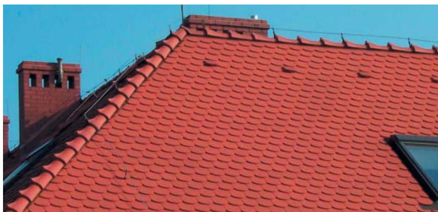
2 Instalacja odgromowa poprowadzona wzdłuż kalenicy (fot. Cerabud) ▼
