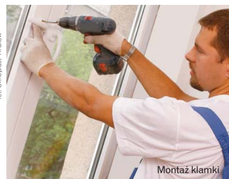
▲ Okno antywłamaniowe z klamką zamykaną na klucz – to jeden ze sposobów dodatkowej ochrony przed nieproszonymi gośćmi
