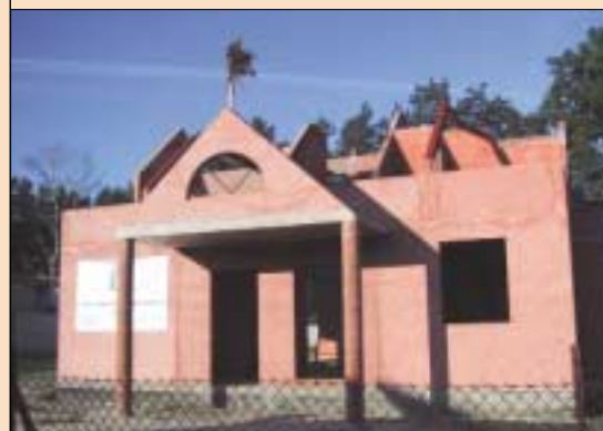
12 Dom wznoszony z wielkoformatowych płyt ściennych keramzytobetonowych (fot. Praefa)
