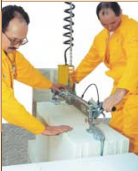
2 Błoczki modułowe o dużych wymiarach (do łączenia na pióro i wpust) przenosi się przy pomocy minidźwigu (fot. archiwum BD)
