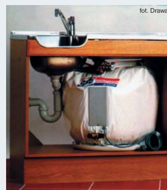
Ten niewielki podgrzewacz pojemnościowy przeznaczony jest do montażu w szafce kuchennej, wykonany jest ze stali nierdzewnej i ma grubą izolację cieplną
