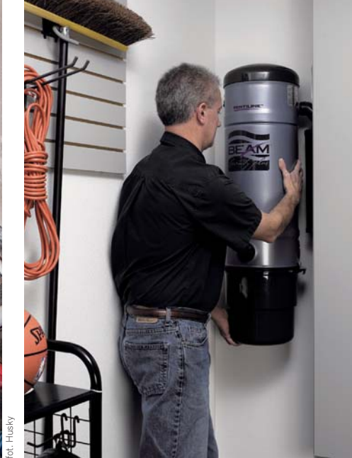
▲ Jednostkę centralną najlepiej zamontować na ścianie w najniższej położonym pomieszczeniu w domu: w garażu lub w pomieszczeniu gospodarczym na takiej wysokości, by mieć do niej swobodny dostęp, aby móc łatwo zdejmować i opróżniać pojemnik na kurz
