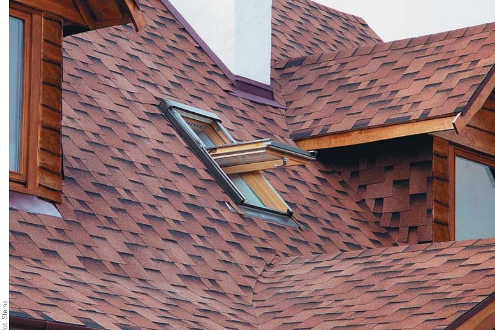
▲ Dachówki bitumiczne doskonale nadają się do krycia dachów o skomplikowanych kształtach
