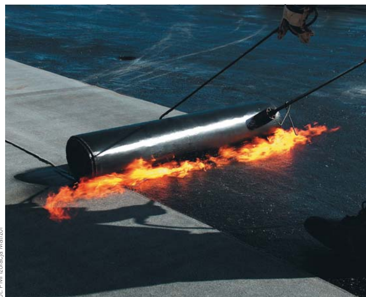
▲ Układanie papy termozgrzewalnej na płaskim dachu
