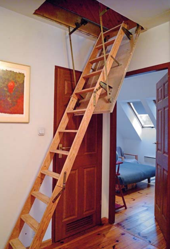
▲ Wejście na strych, na którym znajduje się jednostka zewnętrzna pompy ciepła MY 90, jest możliwe dzięki składanym, drewnianym schodom
