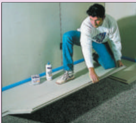
1 Układanie elementów suchego jastrychu z płyt g-w; widać przesunięcie warstw, tworzące złącze nakładkowe (fot. Rigips)
