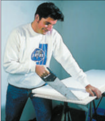
7 Obcinanie wypustu (felcu) ze strony płyty, mającej się znaleźć przy ścianie (fot. Rigips)
