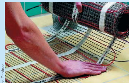
Matą grzejną. Można układać ją także na starej posadzce
