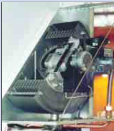
8 Przekrój wymiennika Inox-Radial: spaliny przepływają wąskimi szczelinami między przewodami wodnymi o przekroju prostokątnym; element kulisty w środku to siatka palnika Matrix, na której następuje katalityczne dopalenie gazu
