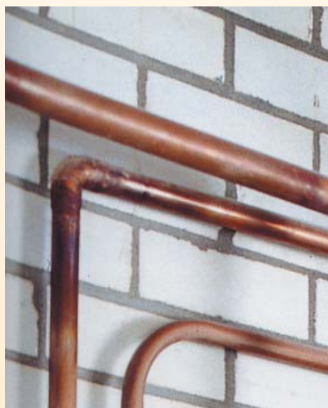
Instalacje wewnętrzne z miedzi prowadzone po wierzchu ścian (fot. archiwum BD)
