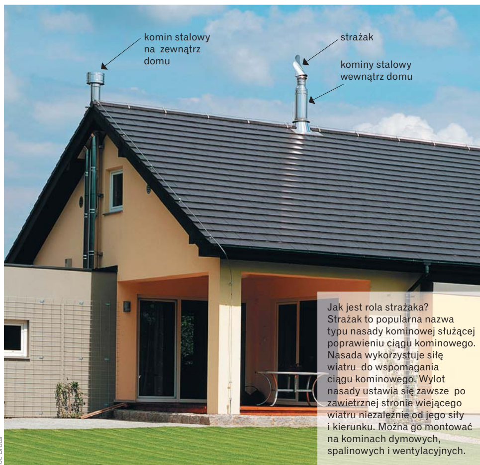
▲ Sposoby prowadzenia komina stalowego
