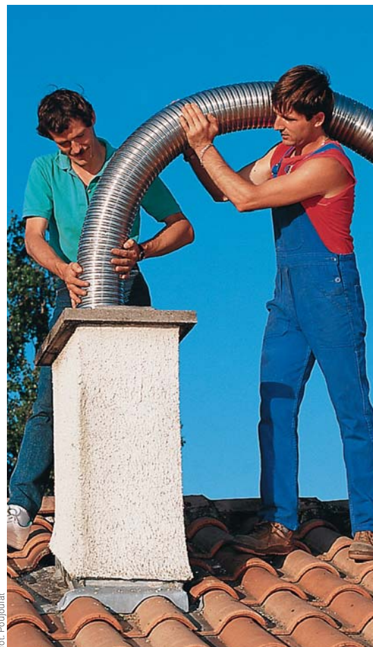
▲ Wprowadzenie wkładu stalowego do komina
