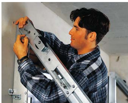
Wstępnie zmontowane prowadnice górne osadza się w ościeżnicy i przymocowuje śrubami
