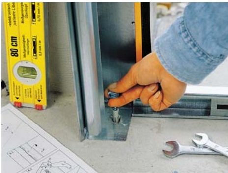
Do podłogi bramę przytwierdza się za pomocą śrub i dybli
