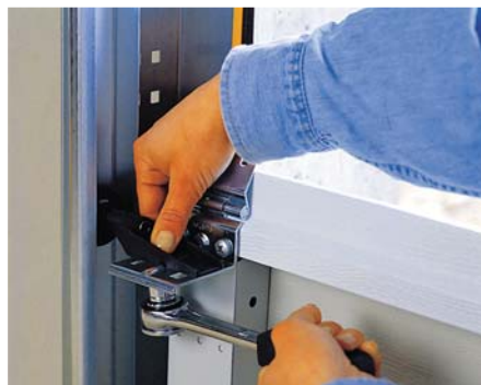
Segmety prowadzone są na rolkach z tworzywa sztucznego. Rolki mocuje się do uchwyty przykręconych do zawiasów zewnętrznych
