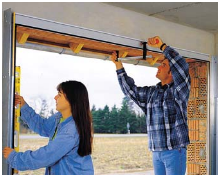
Ramę skrzęconą z czterech profili ustawia się pionowo, dokładnie wyrównuje i unieruchamia w pozycji montażowej
