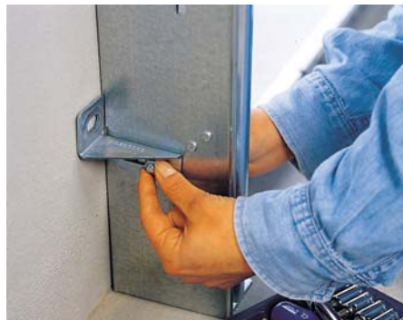
Boczne profile ramy przymocowuje się do ściany garażu, przykręcając kątownik
