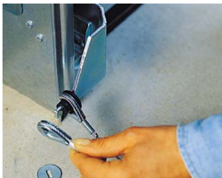
Linkę stalową łączącą bramę ze sprężynami mocuje się na dolnym segmencie przy mocowaniu rolki
