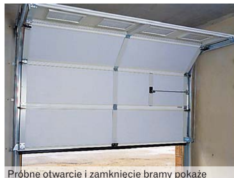
Próbne otwarcie i zamknięcie bramy pokaże nam, czy naciąg linki wymaga dalszej regulacji. Jeśli jest prawidłowy, brama otwarta do połowy powinna się zatrzymać
