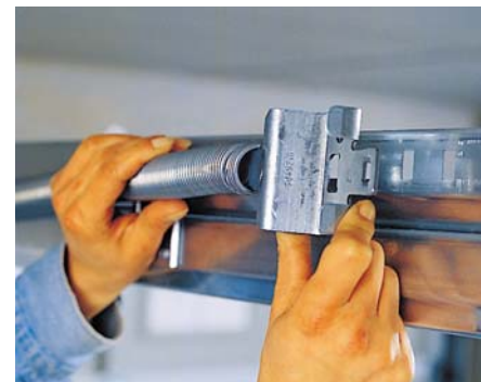
Uruchamia się próbnie bramę i określa się odpowiedni naciąg sprężyn, który umożliwi zrównoważenie jej ciężaru
