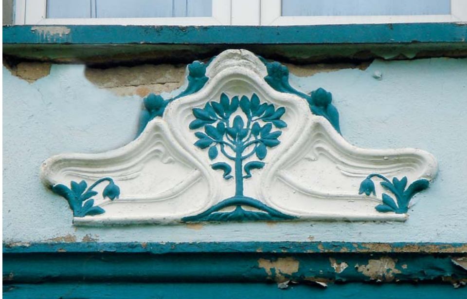
▲ Bardzo czytelny i realistyczny emblemat drzewa nad drzwiami domu. Cały budynek mocno zniszczony, ale płaskorzeźba świeżo odmalowana
