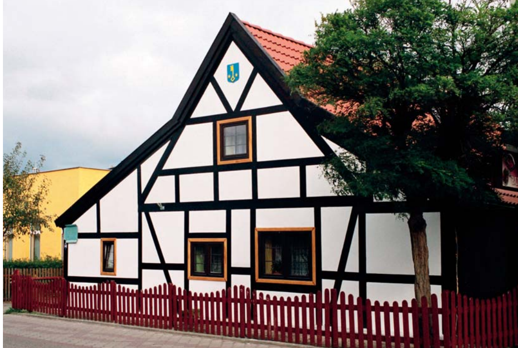
▲ Łeba. Imitacja szachulca pozwala zachować dawny wizerunek domu, w przypadku gdy nie można wyekspozować jego oryginalnej konstrukcji belek
