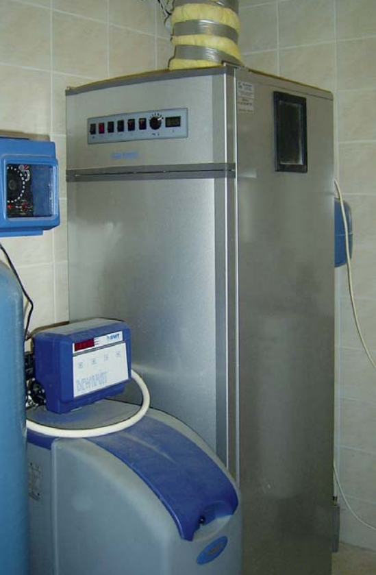
▲ Podgrzewacz wody użytkowej wyprodukowany przez duńską firmę VESTTHERM. Przygotowuje ciepłą wodę użytkową dzięki współpracy z pompą ciepła powietrze-woda
