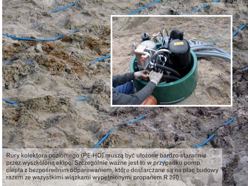
Pompa posadowiona jest na zewnątrz budynku. Podczas układania kolejnych pętli należy zadbać, aby jak najszybciej znalazły się na właściwej głębokości (roboczej). W celu ochrony przed wpływem niskich temperatur, początkowe fragmenty kolektora zabezpiecza się otulinami z poliuretanu
