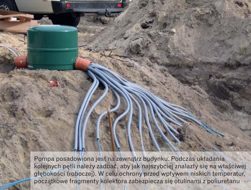
Rury kolektora poziomego (PE-HD) muszą być ułożone bardzo starannie przez wyszkoloną ekipę. Szczególnie ważne jest to w przypadku pomp ciepła z bezpośrednim odparowaniem, które dostarczane są na plac budowy razem ze wszystkimi wiązkami wypełnionymi propanem R 290
