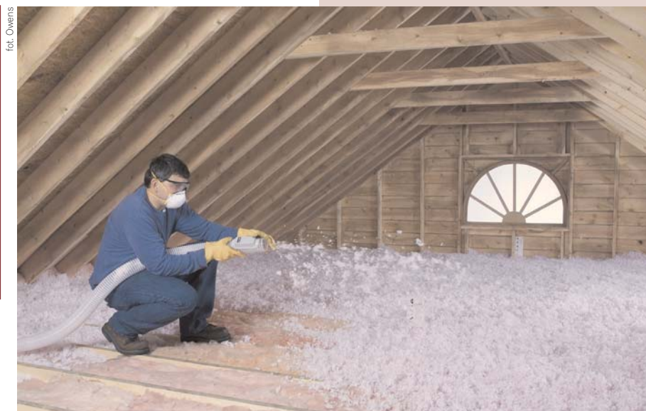
Rys. 4. Wiązba krokwiowo-jętkowa oparta na murłatach
