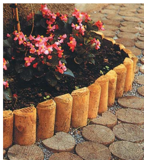
▲ Nawierzchnia z klocków dębowych o okrągłym przekroju
