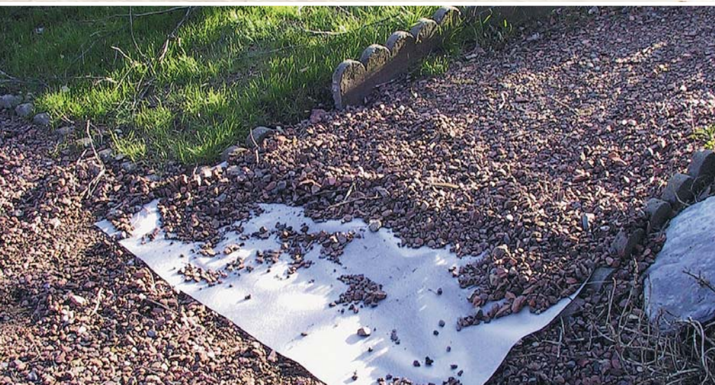
▲ Zastosowanie geowłókniny przy budowie ścieżek i podjazdów przyczynia się do zwiększenia nośności i stabilności nawierzchni, zapobiegając mieszaniu się warstw podbudowy z gruntem rodzimym oraz przerastaniu korzeni roślin (przy jednoczesnym zachowaniu filtracji wody)
