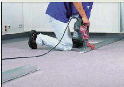
B Mocowanie podłogowego profilu UW na podkładce wyciszającej z taśmy uszczelniającej (fot. Rigips)
