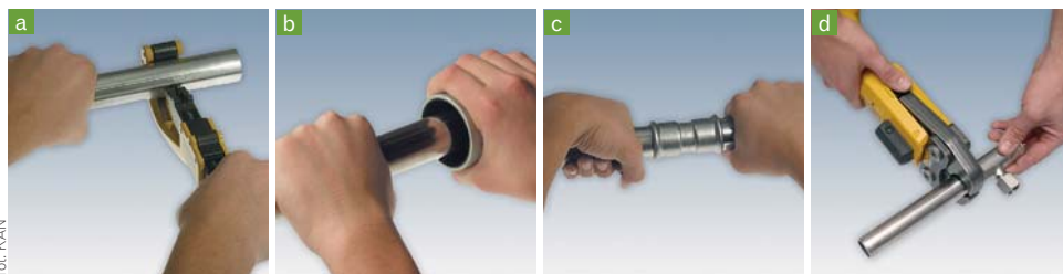
▲ Odcinanie rur (a), fazowanie rur (b), przygotowanie połączenia (c), wykonanie połączenia (d). Wymieniając rury instalacji wod-kan, powinniśmy się zdać na pomoc fachowca
