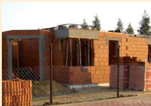
Nadproże betonowe (fol. A. Rembisz)
