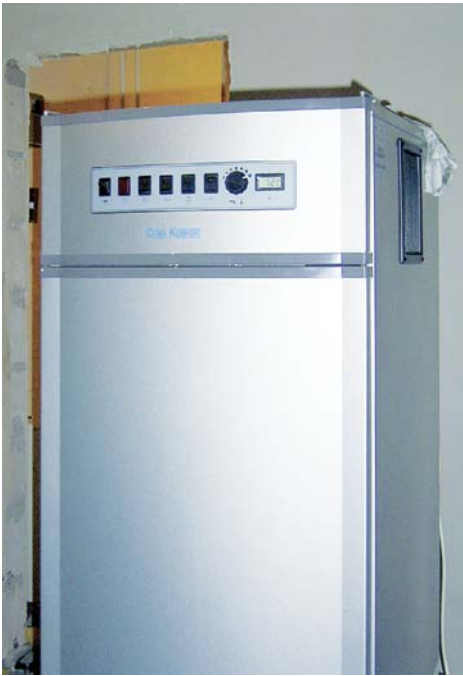
▲ Podgrzewacz wody użytkowej wyprodukowany przez duńską firmę VESTTHERM. Jego najważniejszą część stanowi niewielka pompa ciepła typu powietrze-woda. Przygotowuje ona ciepłą wodę użytkową wykorzystując do tego celu odpowiednio wysoką temperaturę powietrza panującą w pomieszczeniu, w którym się znajduje. Wystarczy już około 5°C, aby pompa skutecznie spełniała swoje zadanie
