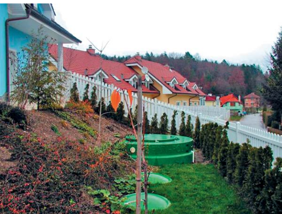
▲ Oczyszczalnia kompaktowa (na zdjęciu ze złożem biologicznym) zajmuje niewiele miejsca, a ścieki są oczyszczone w bardzo wysokim stopniu
