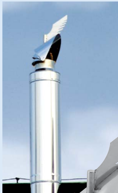
▲ Nasady samonastawne (strażak) stosowane są zarówno na przewodach wentylacyjnych, jak i spalinowych
