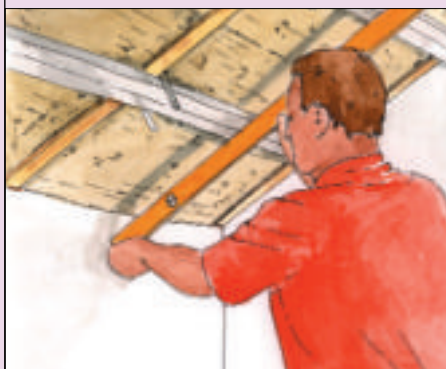
6 ... poziomnicą sprawdzamy, czy profile leżą w tej samej płaszczyźnie ...
