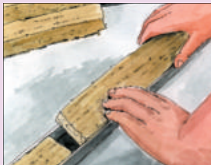
4 ... w profile wkładamy wełnę mineralną ...
