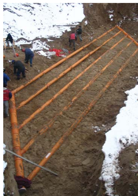
▲ Gruntowy wymiennik ciepła to najczęściej system rur ułożonych w pętłę w gruncie na głębokości 1,5 m. Zimą, podczas dużych mrozów taki wymiennik pozwala na ogrzanie powietrza wchodzącego do budynku, nawet o kilkanaście stopni, bowiem temperatura gruntu na tej głębokości ma zwykle ok. 4–8°C
