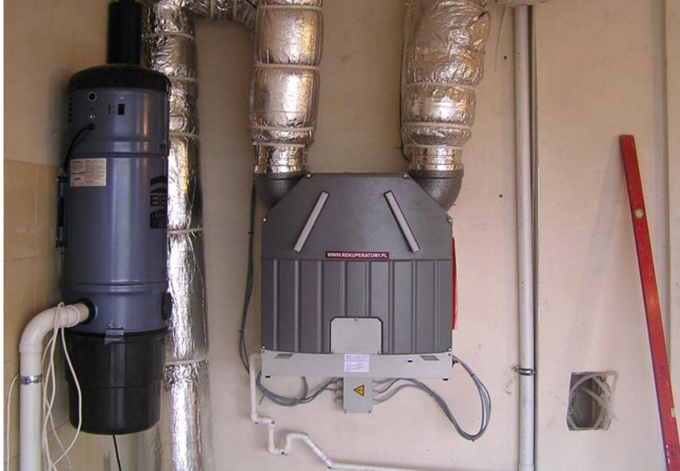
▲ Rekuperator najczęściej montuje się na poddaszu, w kotłowni lub w garażu, w miejscu zapewniającym łatwy dostęp do urządzenia, by 3–4 razy do roku wyjąć i wyczyścić filtry
