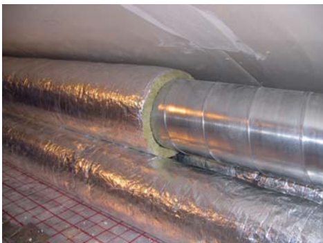
▲ Kanały można ukrywać w ścianach i stropach, a w budynkach z nieużytkowym poddaszem najczęściej prowadzi się je właśnie w tej niewykorzystanej przestrzeni
