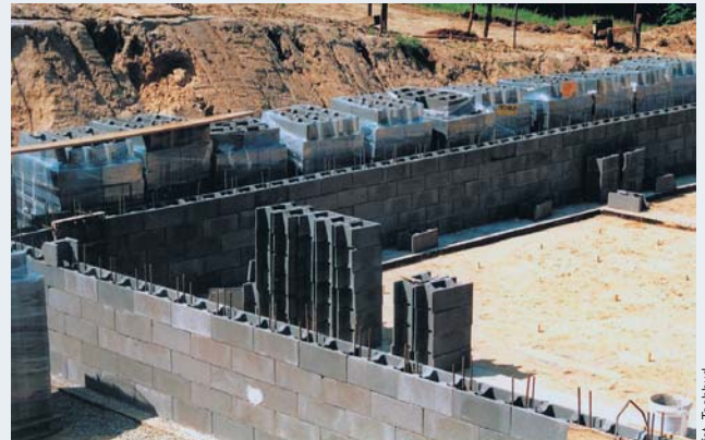
Ściany piwnic można budować np. z betonowych bloczków zasypowych lub z pustaków z wkładką styropianową
