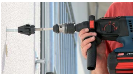
Montaż systemu Thermax
