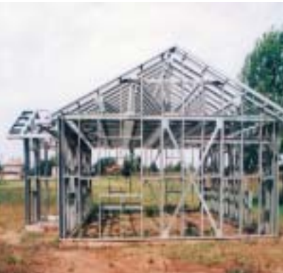
Budując w technologii szkieletu stalowego, należy zadbać o szczególnie staranne ocieplenie miejsc przebiegu profili; pozwoli to uniknąć mostków termicznych (fot. AmTech)
