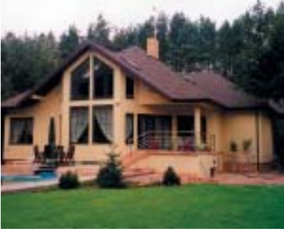
Jeśli chcemy szybko wprowadzić się do nowego domu, budynek w technologii szkieletu drewnianego będzie właściwym rozwiązaniem (fot. Top Bud)
