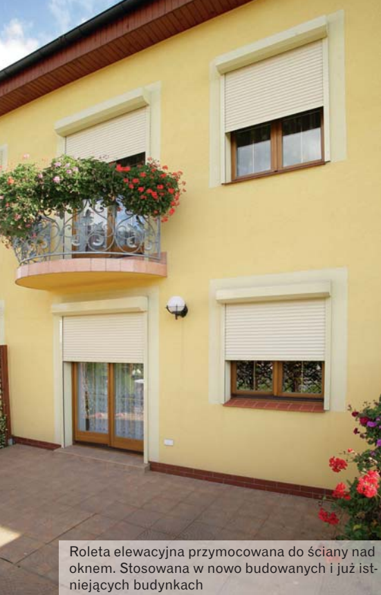
Roleta naokienna, stosowana w budynkach nowo budowanych i już istniejących
