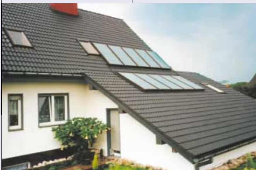
7 Kolektory umieszczone w połaci dachowej (fot. WATT)
