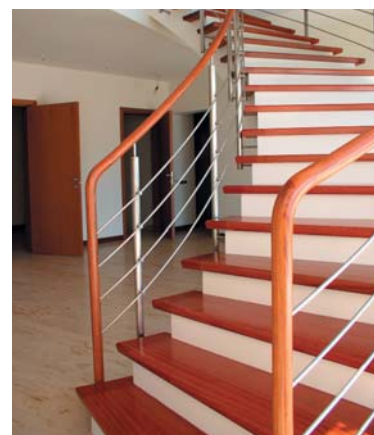
6 Na schodach żelbetowych dobrze wygląda „lekkie” drewno (fot. Stajder)
