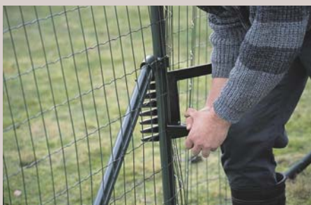
▲ Siatki zgrzewane. Mocuje się je do słupków klipsami i naciąga specjalnym grzebieniem
