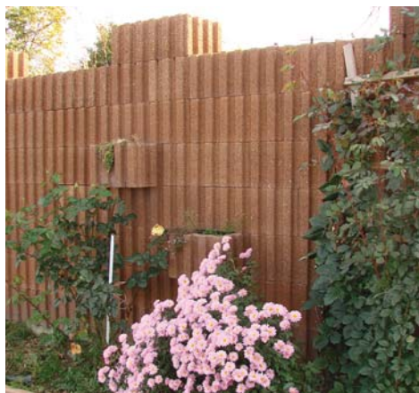
▲ Mury pełne z elementów betonowych. Można obsadzić je zielenią – w ten sposób utworzą solidniejszą zaporę przed hałasem i zanieczyszczeniami
