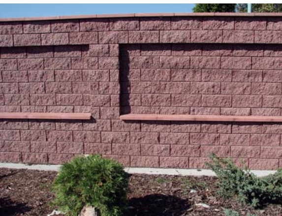
▲ Mury pełne z elementów betonowych. Można obsadzić je zielenią – w ten sposób utworzą solidniejszą zaporę przed hałasem i zanieczyszczeniami
