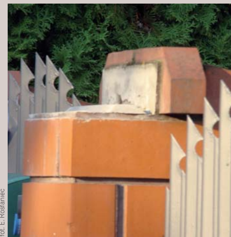
▲ Przed założeniem nowych daszków trzeba dokładnie oczyścić miejsce, w którym były zamocowane – usunąć pozostałości po kleju montażowym, tak aby daszek przylegał całą swoją powierzchnią do cegły bądź podmurówki
