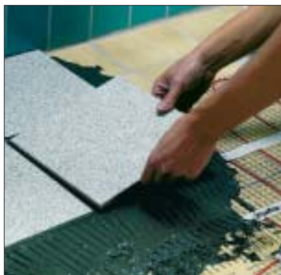
Maty pokrywa się warstwą zaprawy klejącej, a do niej bezpośrednio przymocowuje płytki podłogowe (fot. Devi)
