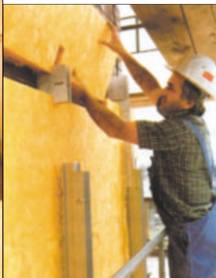
8 Do ocieplenia ścian zaleca się stosować płyty z wełny mineralnej półtwarde (fot. Isover Gullfiber)
