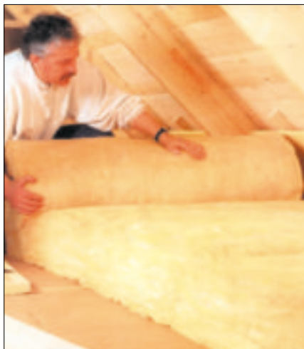
12 Do izolowania stropodachów znakomicie nadają się maty z wełny mineralnej (fot. Isover Gullfiber)
