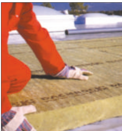
16 Twarde płyty wełny mineralnej są dobrym podłożem pod pokrycie z papy (fot. Rockwool)
