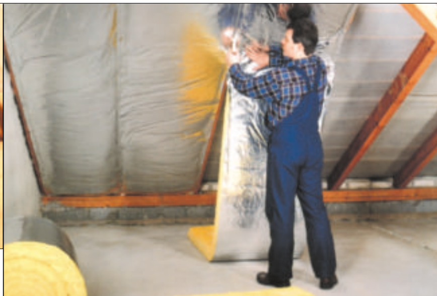
14 Stosując na poddaszach wełnę laminowaną folią aluminiową nie trzeba układać folii paroizolacyjnej (fot. Ursa Pflleiderer)
