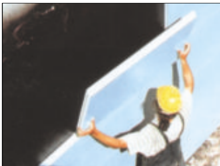
6 Polistyren ekstrudowany jest mało nasiąkliwy, dlatego chętnie wykorzystuje się go do ocieplania ścian fundamentowych (fot. Austrotherm)
