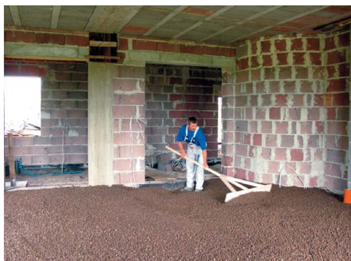
▲ Kruszywo keramzytowe zastępuje kilka warstw tradycyjnej podłogi, co przyspiesza pracę
