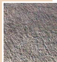
foto. DACH REED
