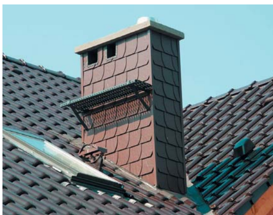
7 Kominą prefabrykowane często wykańcza się płytkami ceramicznymi (fot. Schiedel)
