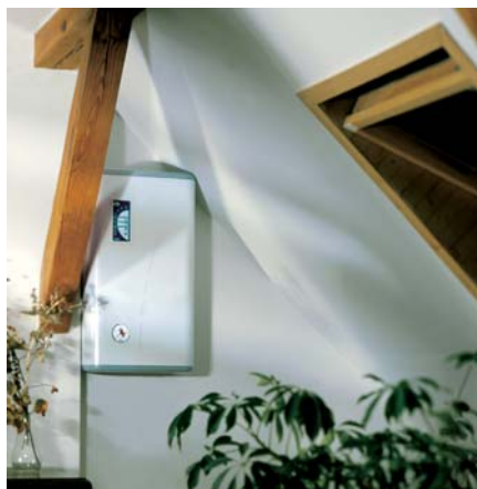
1 Kocioł elektryczny zajmuje niewiele miejsca i może być zamontowany w dowolnym pomieszczeniu (fot. Kospel) ▲
