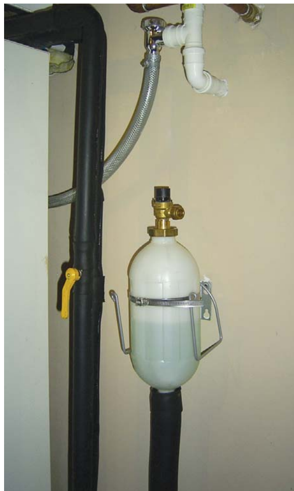
▲ Pompa wraz z całą instalacją znajduje się w pomieszczeniu gospodarczym, gdzie umieszczone są również pozostałe elementy instalacji. Czynnikiem krążącym w kolektorze pionowym (studnia 110 m głębokości) jest glikol
