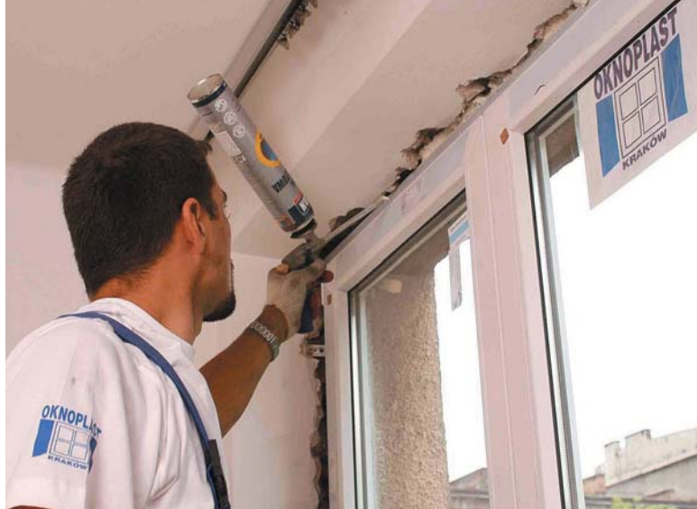
▲ Przy montażu okien bardzo ważne jest precyzyjne wypełnienie pianką szczeliny między oknem a ścianą
